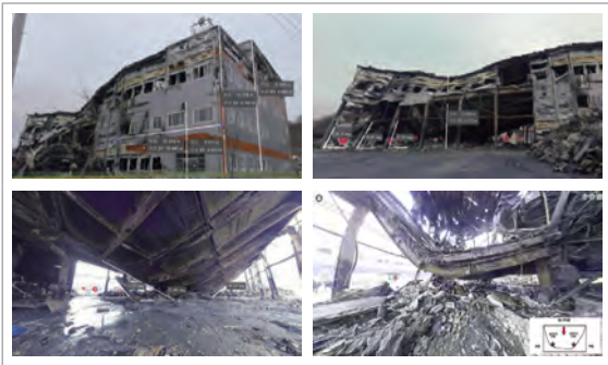
〈그림 6〉 경북 문경 화재 순직사고 현장 3D 스캐닝 측정
