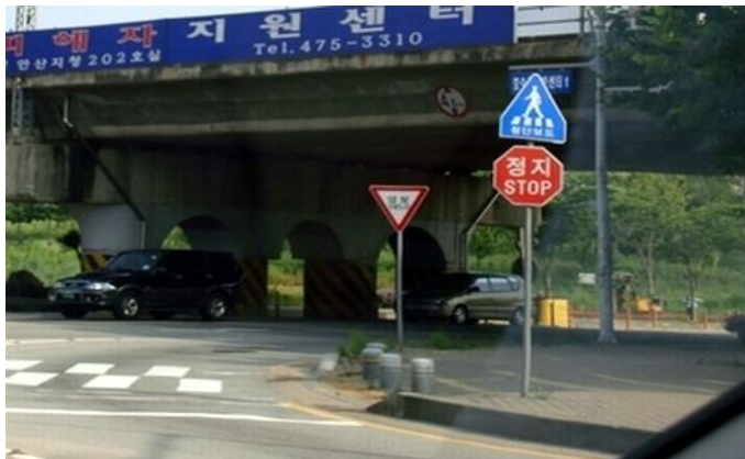
<그림 3-14> 일시정지와 양보 안전표지 혼재 설치 사례 6
