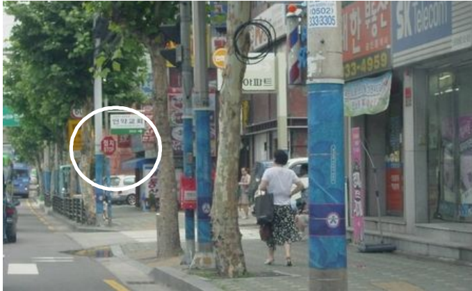
<그림 3-20> 방향이 틀리게 설치된 일시정지 안전표지 설치 사례 1
