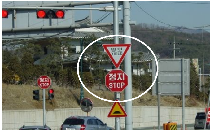
<그림 3-12> 일시정지와 양보 안전표지 혼재 설치 사례 4
