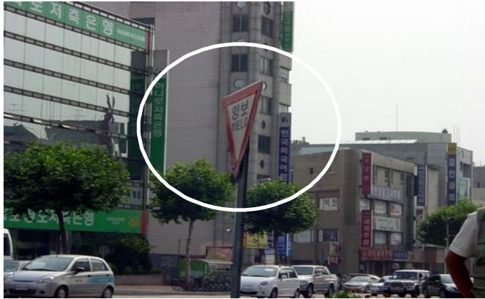
〈그림 3-18〉 방향이 틀리게 설치된 양보 안전표지 설치 사례 2
