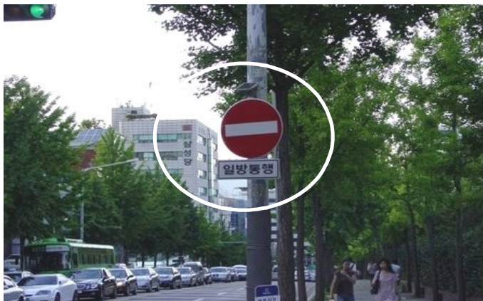
<그림 3-34> 잘못된 일방통행 안전표지 방향 설치 사례
