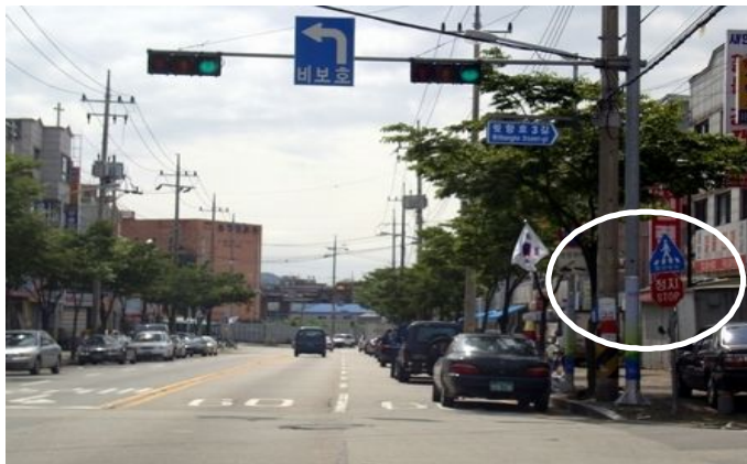
<그림 3-6> 교통신호기와 일시정지 안전표지 혼재 설치 사례 3
