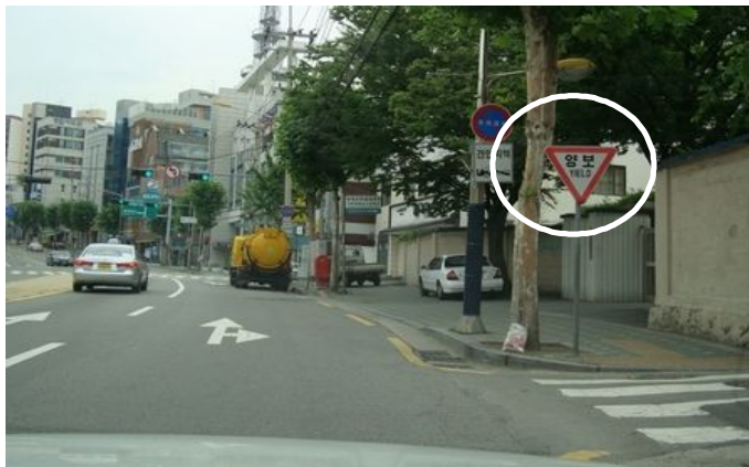
<그림 3-17> 방향이 틀리게 설치된 양보 안전표지 설치 사례 1
