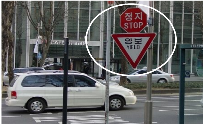
<그림 3-9> 일시정지와 양보 안전표지 혼재 설치 사례 1
