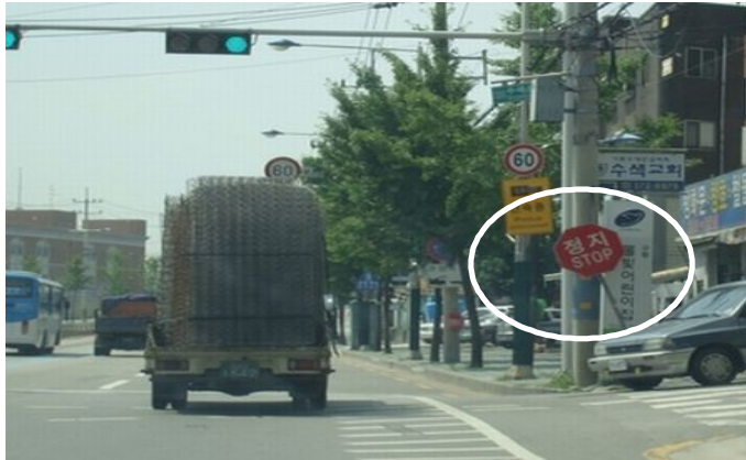
〈그림 3-22〉 방향이 틀리게 설치된 일시정지 안전표지 설치 사례 3
