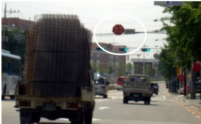
<그림 3-25> 도로 링크부에 설치된 일시정지 안전표지 설치 사례
