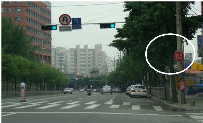
<그림 3-4> 교통신호기와 일시정지 안전표지 혼재 설치 사례 1
