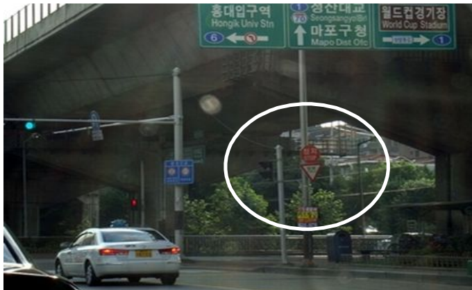
<그림 3-11> 일시정지와 양보 안전표지 혼재 설치 사례 3
