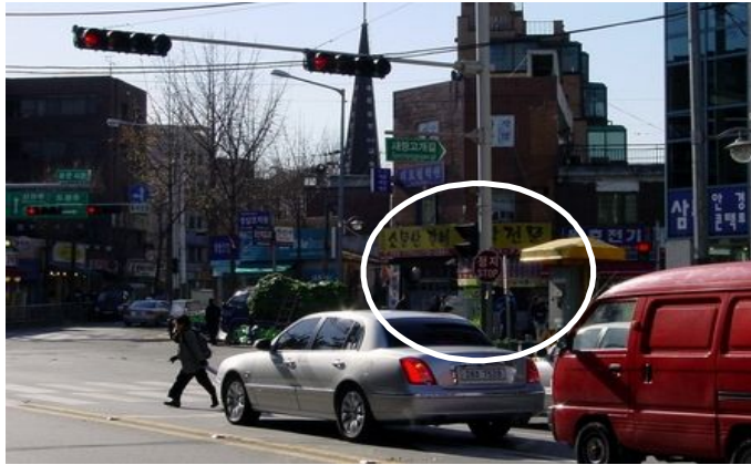
<그림 3-5> 교통신호기와 일시정지 안전표지 혼재 설치 사례 2
