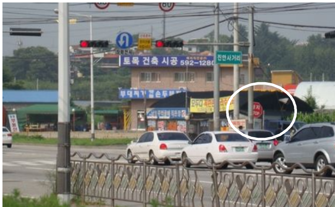
<그림 3-7> 교통신호기와 일시정지 안전표지 혼재 설치 사례 4
